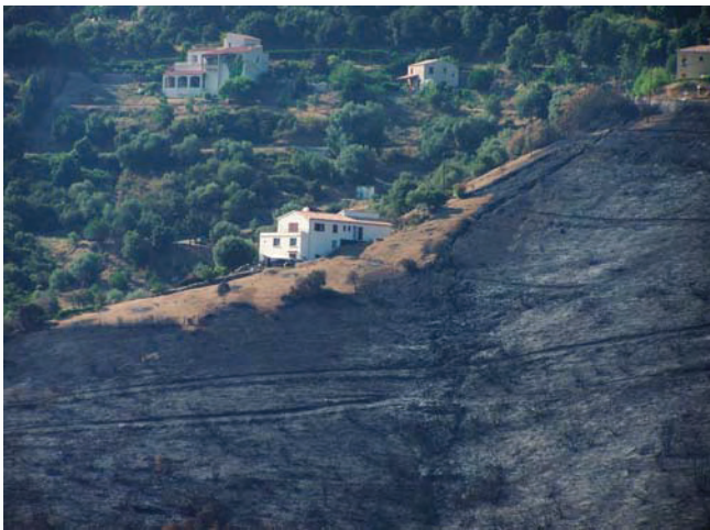
Passage du feu sur débroussaillage - Feu Salario juillet 2006
