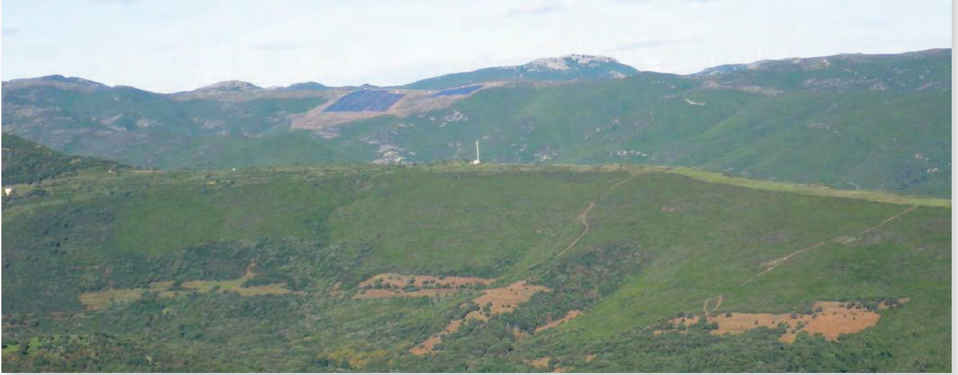
Implantation photovoltaïque sur la ZAL de Méria
