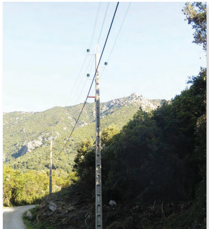
Lignes électriques débroussaillées
