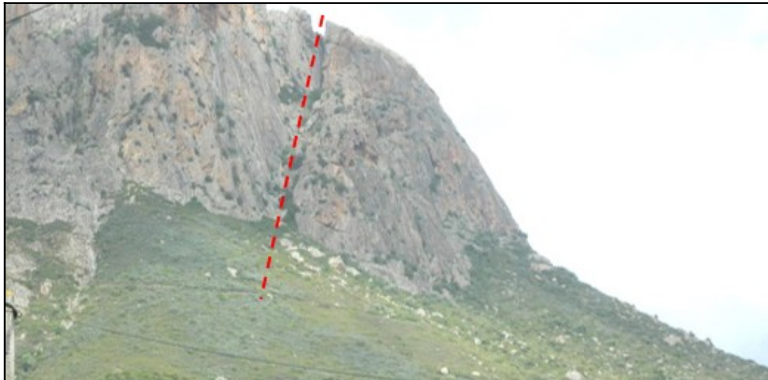
Figure 9 : Couloir de faille du Rocher du Gozzi, surmonté par des parois rocheuses orientées selon la famille F1 N60°E influençant la concentration des trajectoires de blocs (avec dispersion au pied du couloir)
