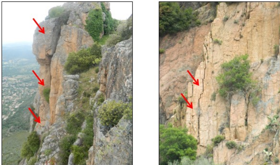
Figure 22: Exemples de rupture possible de colonnes en pied (à gauche partie sommitale du Rocher des Gozzi, à droite secteur de Piscia Rossa)
