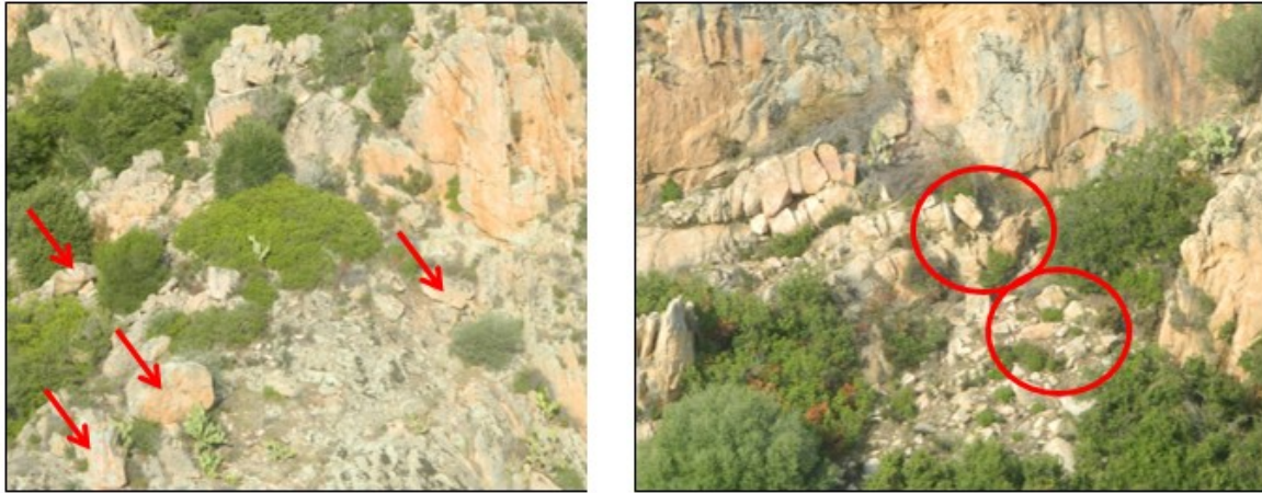
Figure 24: Exemples de blocs potentiellement remobilisables en amont de Piscia Rossa
