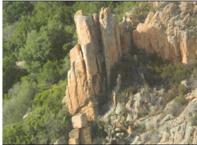
Figure 21: Exemples de rupture possible par basculement de colonnes ou de blocs de volumes décimétriques à pluridécimétriques (en amont de Piscia Rossa)
